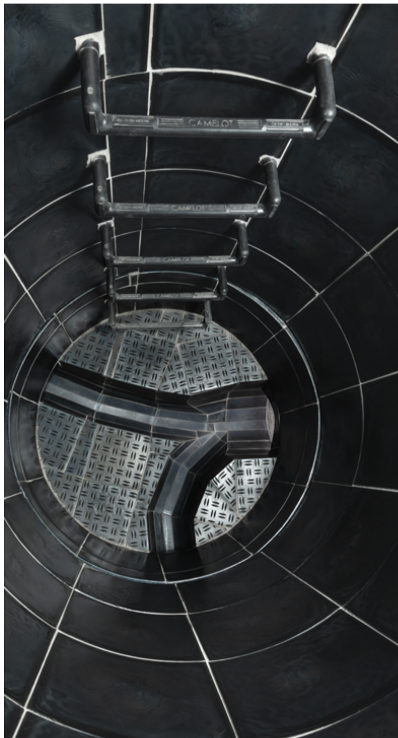
Vnitřní obklad spadišťové šachty čedičem
