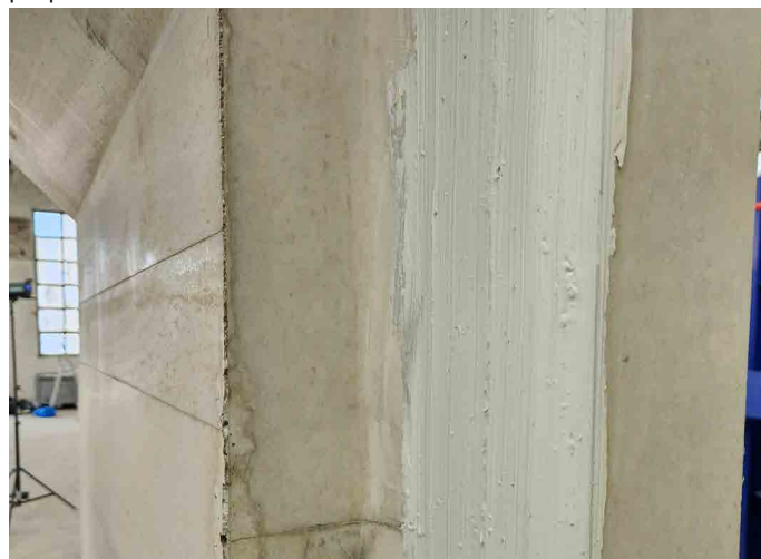
Obr. 4 Ukázka aplikace kluzného prostředku na dříku s těsněním rámové propusti
