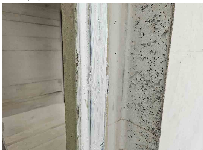
Obr. 5 Doporučená vnější spára rámových propustí před zahájením spojování řetězovým stahovákem
