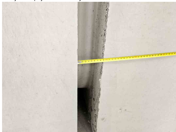
Obr. 5 Doporučená vnější spára rámových propustí před zahájením spojování řetězovým stahovákem
