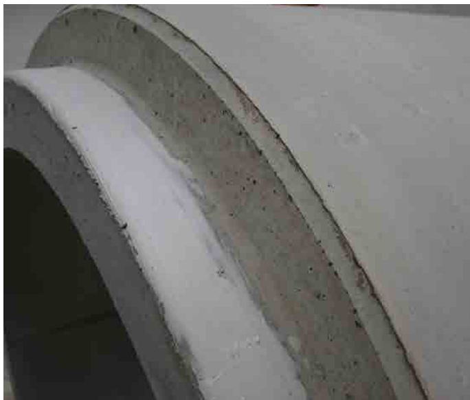
Obr. 6 Detail vnitřní spáry po spojení trub
