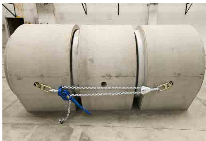
Obr. 5 Detail uložení pákového zvedáku RZC s článkovým řetězem na jedné straně trouby
