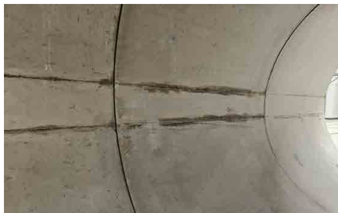
Obr. 6 Detail vnitřní spáry po spojení trub
